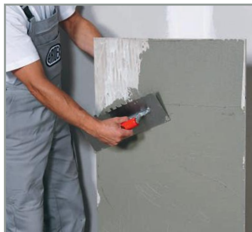
Migliore aderenza: con gli adesivi ARDEX MICROTEC X78 e S28 NUOVO, posati con la tecnica buttering-floating
