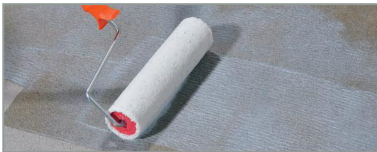
Ideale per massetti in solfato di calcio: mano di fondo idrorepellente con ARDEX P51
