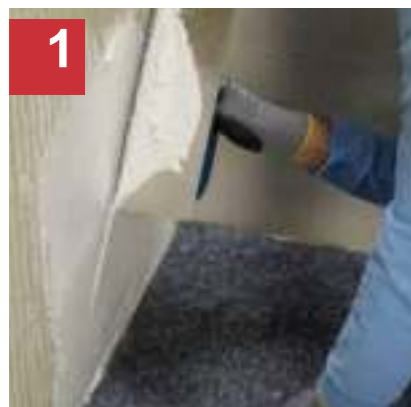
1 Pareggiare il sottofondo con ARDEX R1 Filler per ristrutturazione.
