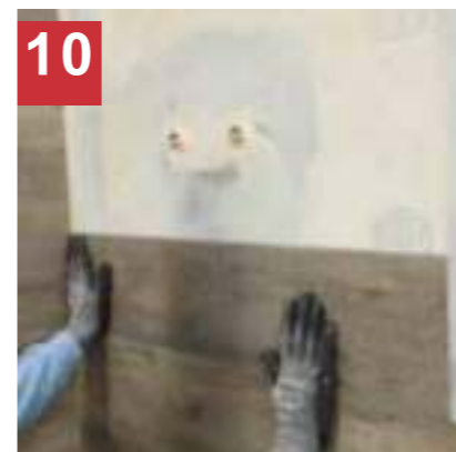
10 Giuntare la pavimentazione di design in PVC con la parete utilizzando ARDEX AF 181 W. Raccogliamo l'applicazione finale di un rivestimento protettivo sulla pavimentazione di design in PVC.
