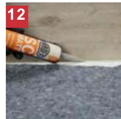
12 Sigillare i giunti con silicone.
