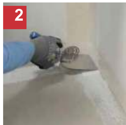
2 Angolari sigillanti ARDEX TRICOM fissati con ARDEX AF 181 W.
