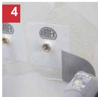
4 Manicotti ARDEX TRICOM fissati con ARDEX AF 181 W.
