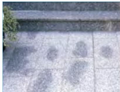
L'umidità accumulata negli strati di malta conduce inevitabilmente a danni da umidità o macchie.
